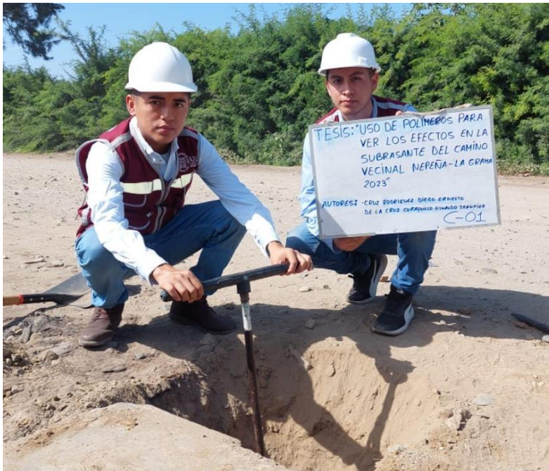
Figura 10 Excavación y obtención de muestras de suelo de la calicata 01
