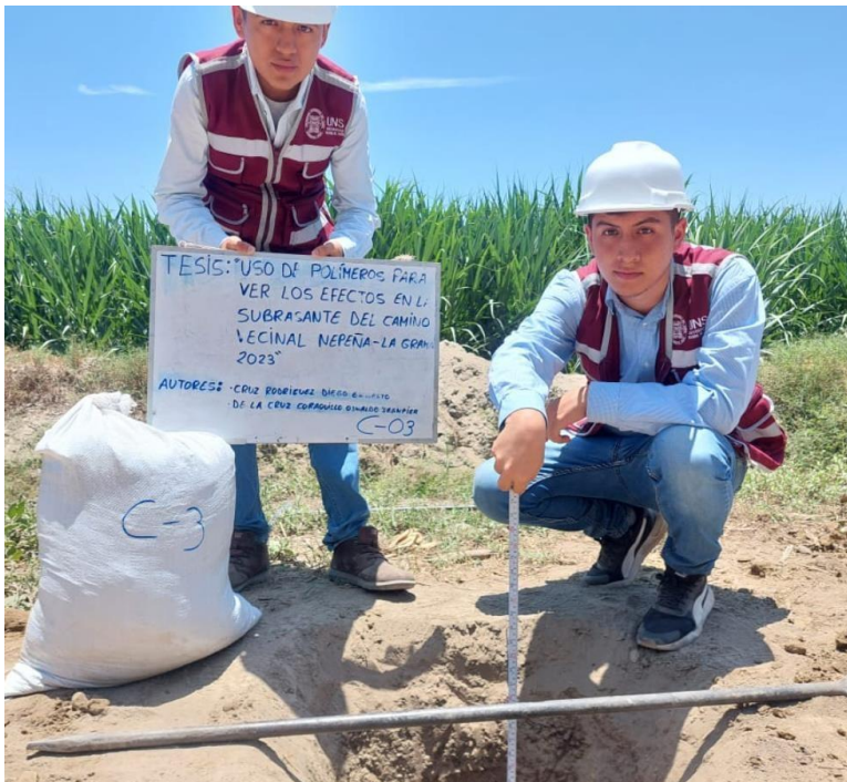
Figura 12 Excavación y obtención de muestras de suelo de la calicata 03
