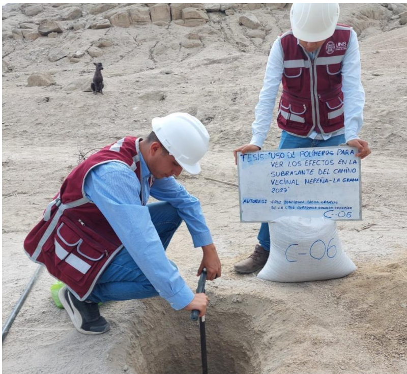
Figura 15 Excavación y obtención de muestras de suelo de la calicata 06
