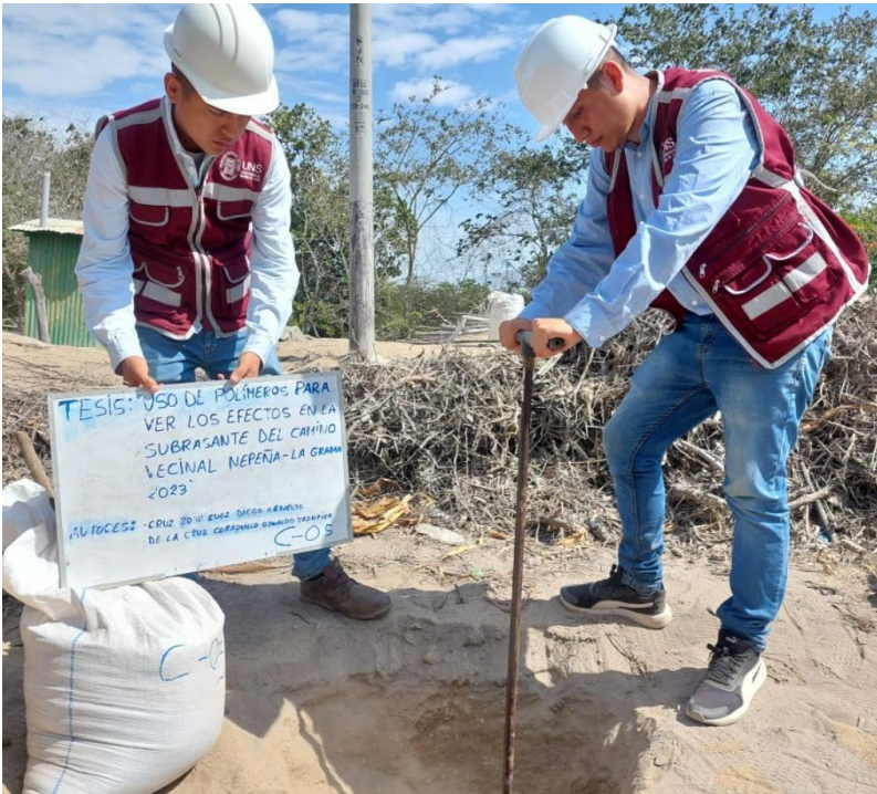
Figura 14 Excavación y obtención de muestras de suelo de la calicata 05
