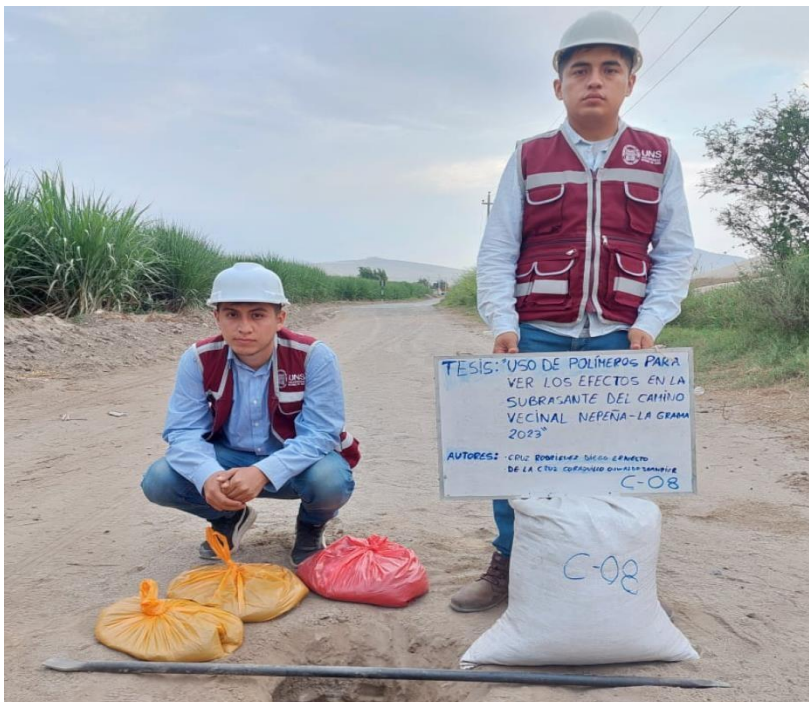
Figura 17 Excavación y obtención de muestras de suelo de la calicata 08
