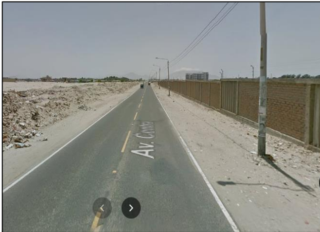
Foto 3. Desmonte acumulado en Av. Central costado de UNS.
