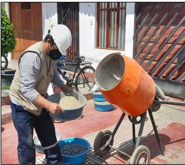
Fotografía 10. Proporciones de mezcla para concreto reciclado
