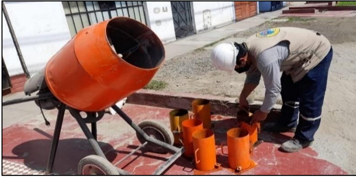
Fotografía 9. Preparación de moldes para especímenes de concreto.
