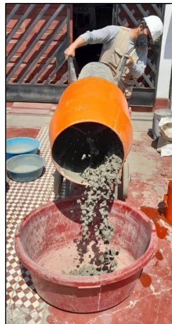
Fotografía 11. Batimiento de mezcla en trompito durante 2 min.
