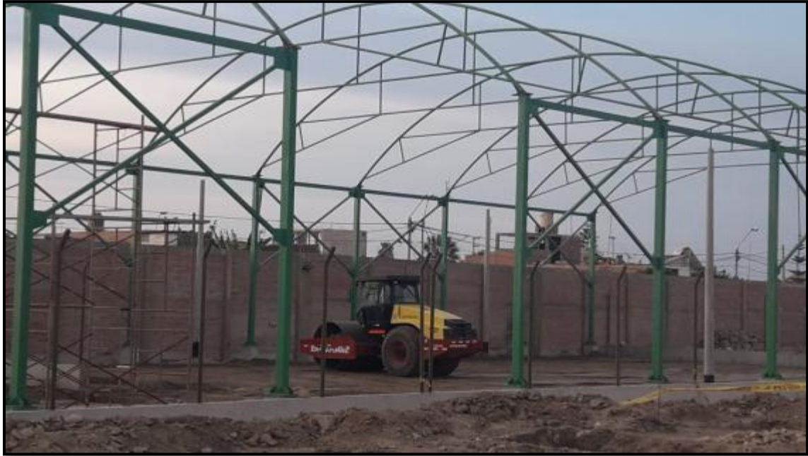
FOTO N°15. COMPACTACION DE BASE GRANULAR E=0.15 m EN CAMPO DE GRASS SINTETICO.
