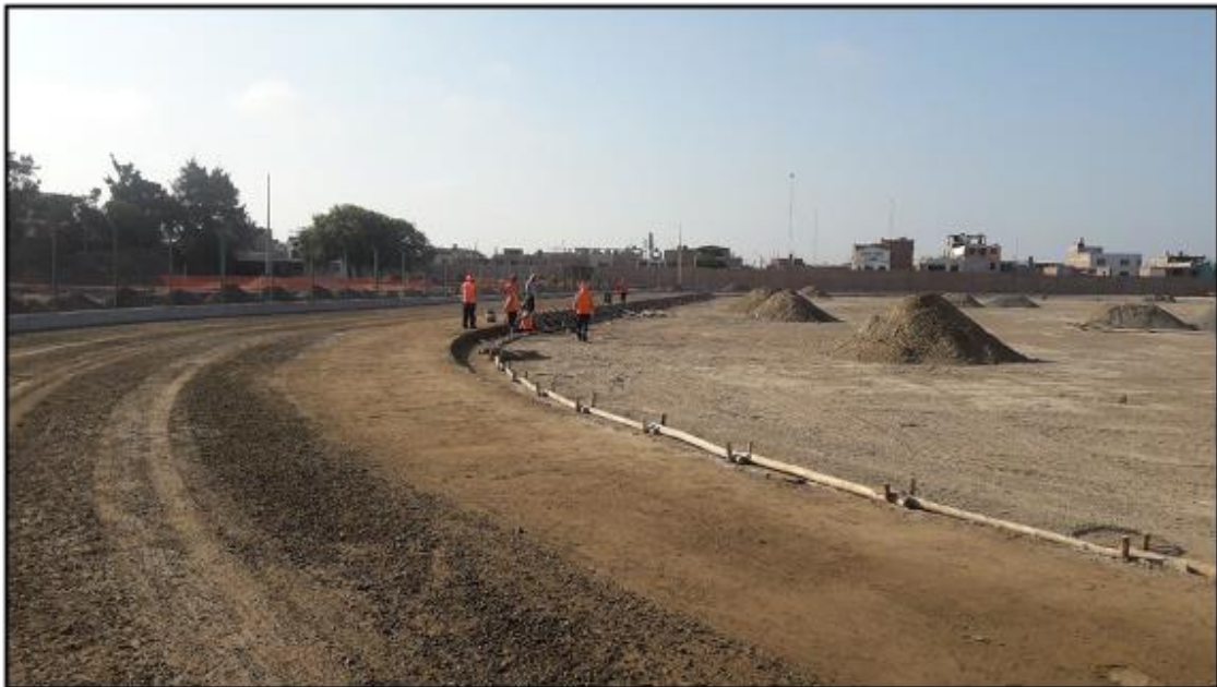
FOTO N°14. ENCOFRADO DE SARDINEL PERALTADO EN PISTA ATLETICA.
