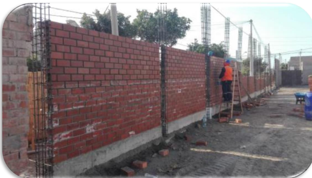
FOTO N° 08. SE PUEDE APRECIAR EL ASENTADO DE LADRILLO DEL CERCO PERIMETRICO.
