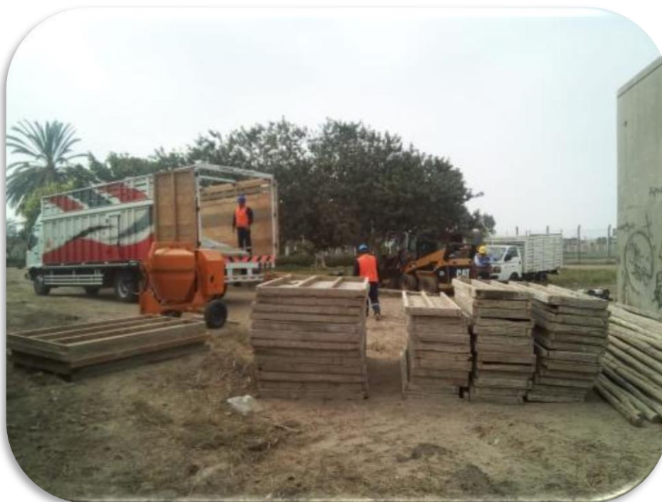
FOTO N°02. DESCARGA DE PANELES PARA ENCOFRADO Y ARMADO DE ALMACEN Y OFICINA
