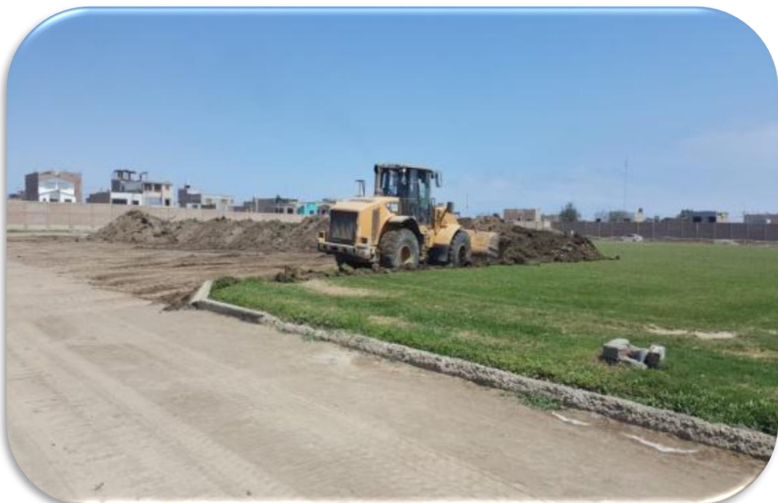
FOTO N°04. PODEMOS APRECIAR LA EXCAVACION DEL CAMPO DEPORTIVO CON MAQUINARIA CARGADOR FRONTAL.
