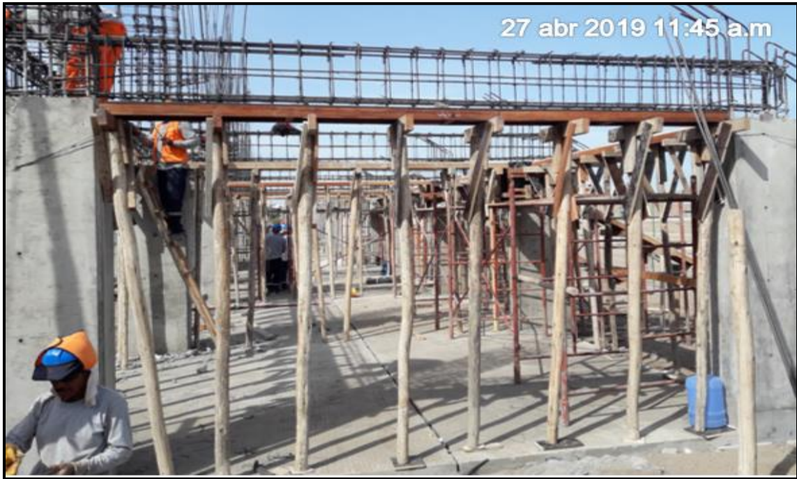
FOTO N°17. CONEXIÓN DE ACERO CORRUGADO FY=4200 \text{ Kg/cm}^2 GRADO 60 EN VIGA
