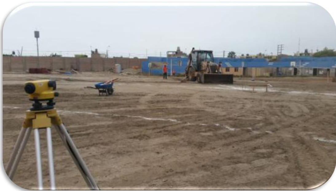
FOTO N°11. SE PUEDE OBSERVAR LOS TRABAJOS DE NIVELACION DE LA PISTA ATLETICA Y CAMPO DE FUTBOL.
