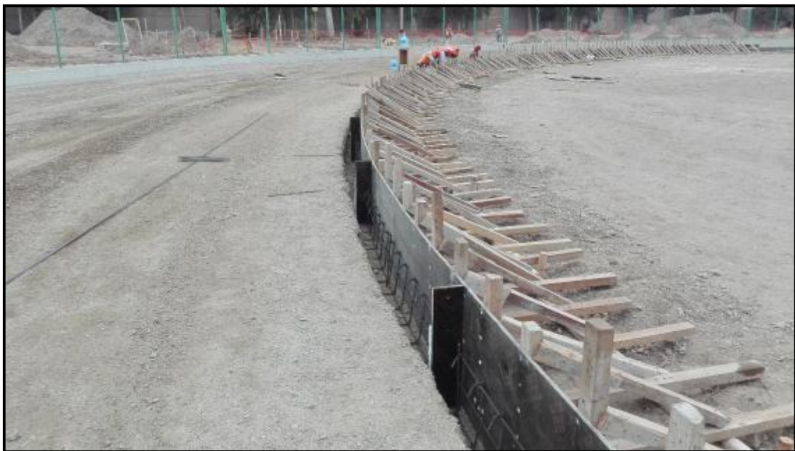
FOTO N°16. COLOCACION DE ACERO DE REFUERZO EN SARDINELES PERALTADOS CON SUS RESPECTIVAS JUNTAS DE DILATACION.
