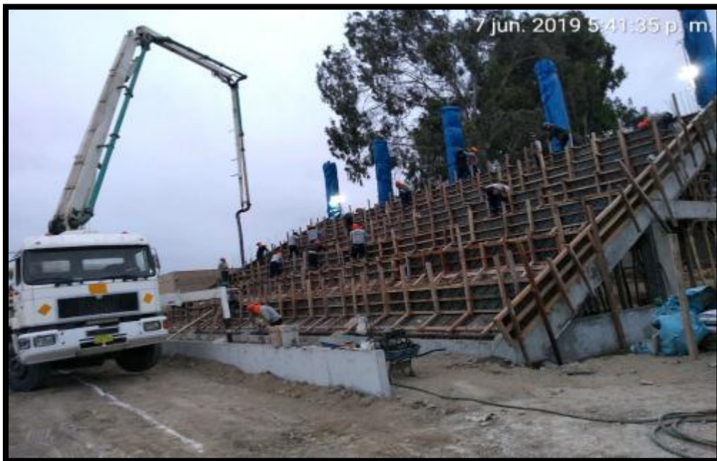
FOTO N°20. COLOCACION DE CONCRETO F'C=210 Kg/cm2. DE GRADERIA EN TRIBUNAS
