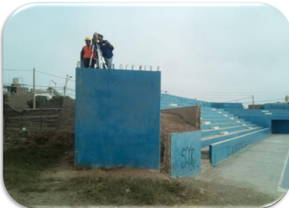
FOTO N°01. LEVANTAMIENTO TOPOGRAFICO PARA EL TRAZO Y REPLANTEO DEL PROYECTO
