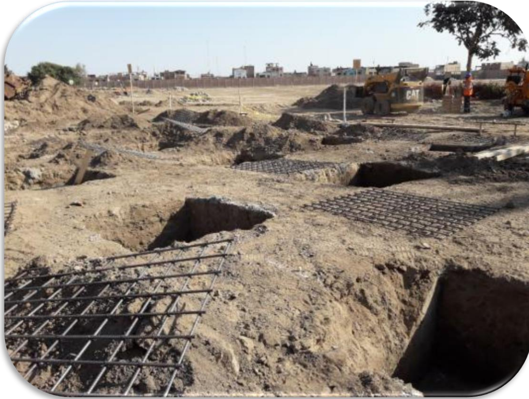
FOTO N° 09. SE PUEDE OBSERVAR EL ACERO PARA ZAPATAS EN LAS OFICINAS ADMINISTRATIVAS.
