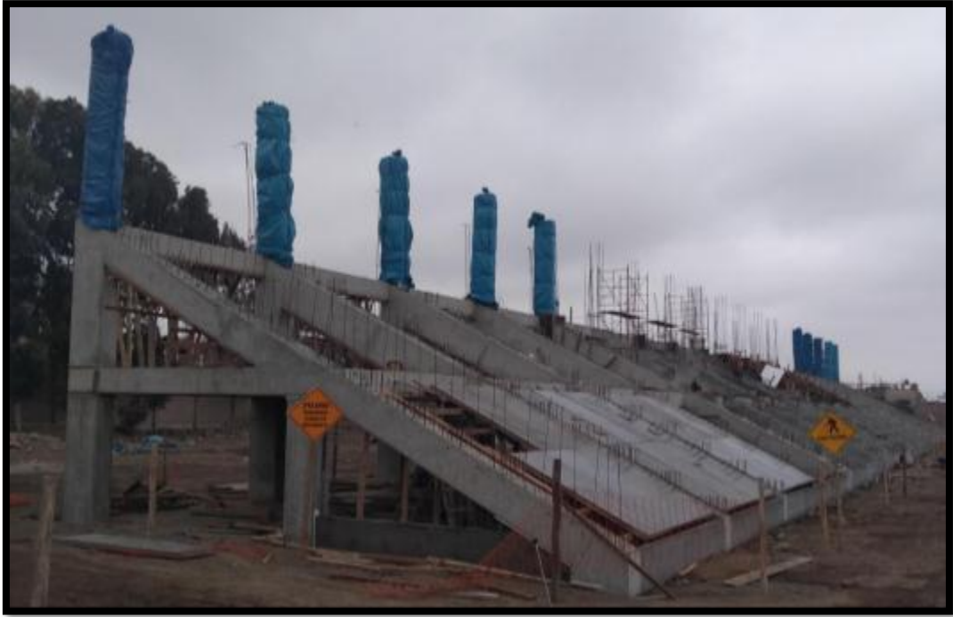
FOTO N° 19. GRADERIA MODULO B: CONCRETO ARMADO
