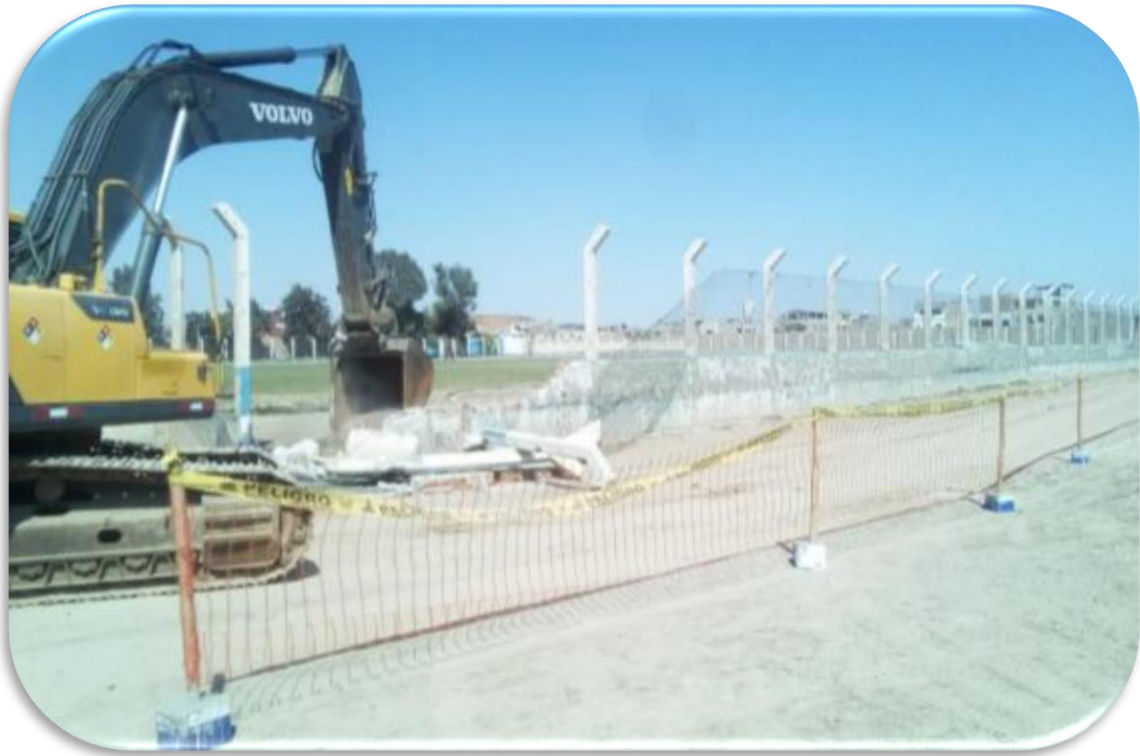
FOTO N°03. PODEMOS APRECIAR LA DEMOLICION DEL CERCO OLIMPICO CON MAQUINARIA EXCAVADORA Y MALLA DE SEGURIDAD.
