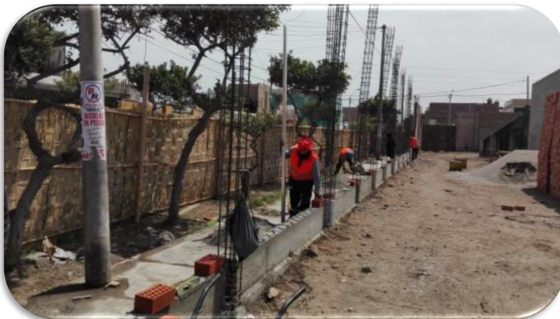
FOTO N° 07. SE PUEDE APRECIAR EL DESENCOFRADO DE SOBRECIMIENTO Y ASENTADO DE LADRILLO PARA CERCO PERIMETRICO.
