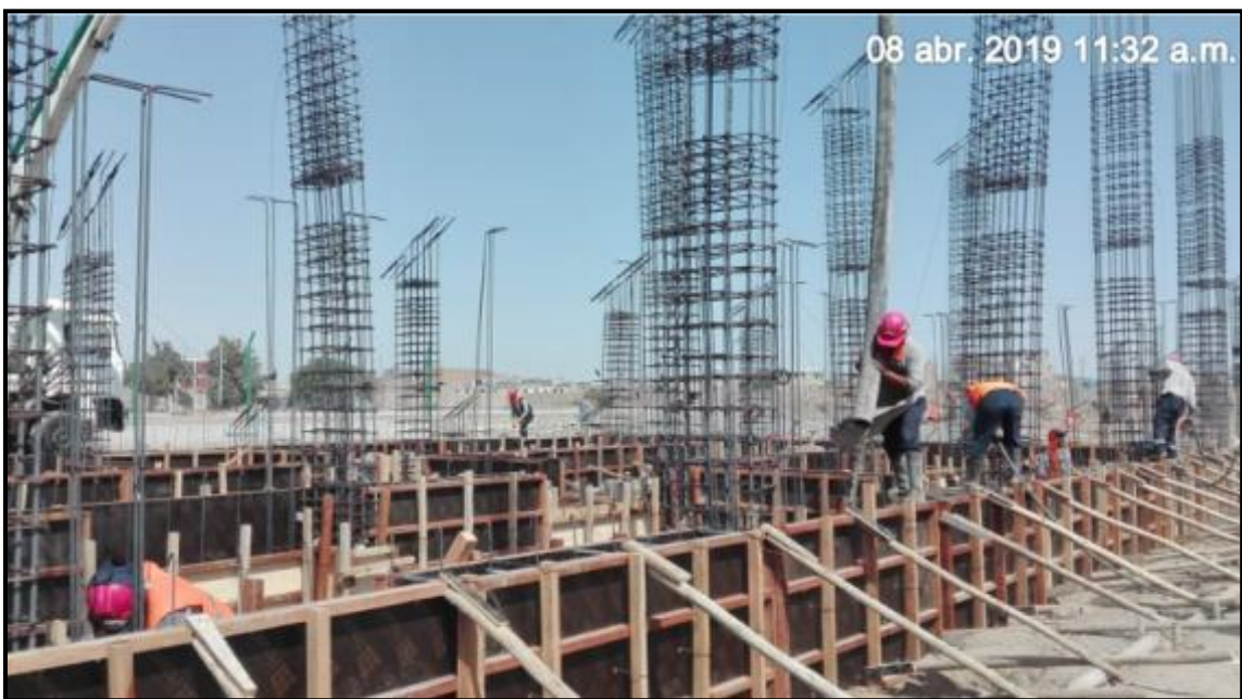
FOTO N°18. COLOCACION DE CONCRETO CICLOPEO 1:8+25% P.M EN
