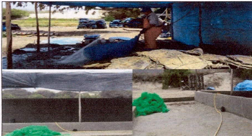
Figura 13. Lavado y reparado de sistemas en el distrito de Samanco.
