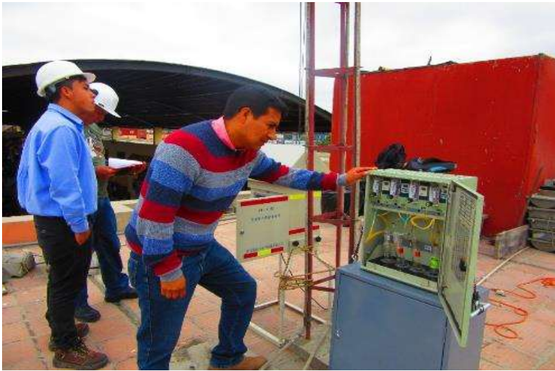
Estación de monitoreo ubicada en el terminal terrestre El Chimbador.
