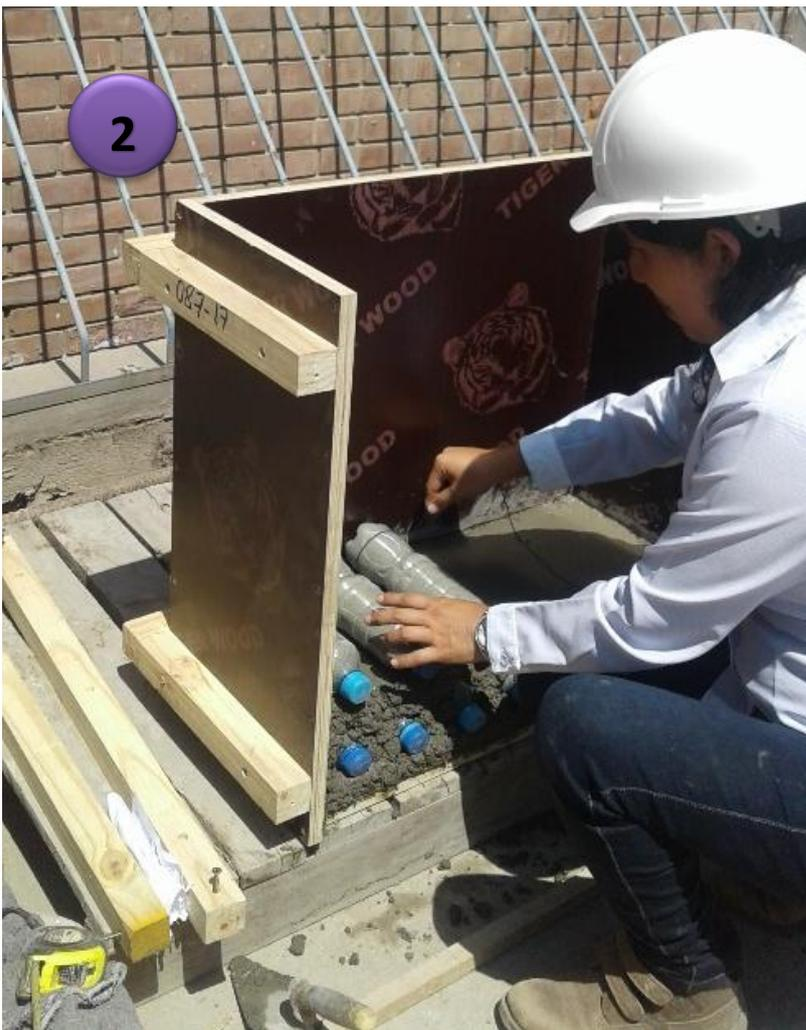
Figura 12: Elaboración de Muretes tipo PET, usando ladrillos tipo PET, mortero e hilo nylon.
